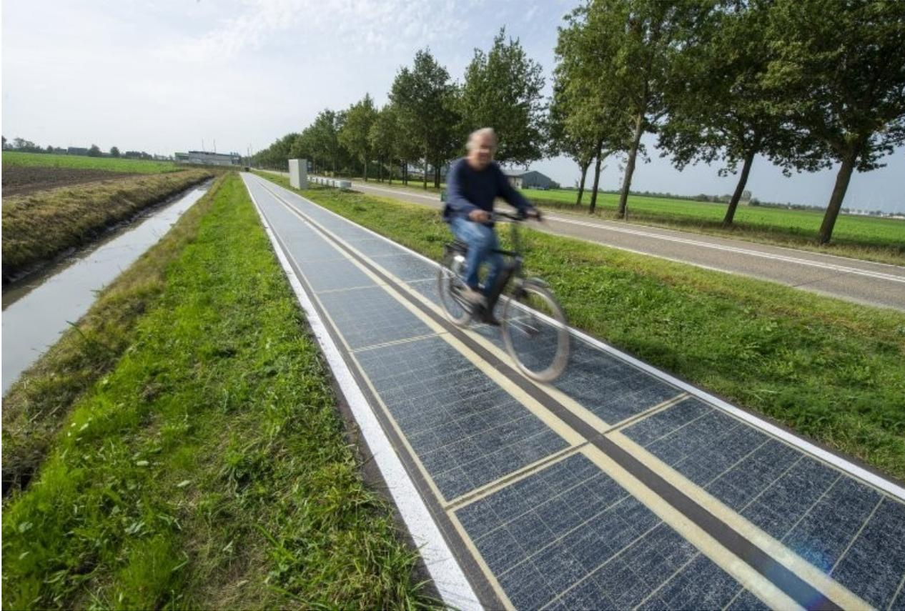
Wattway wird mit einem neuartigen Solarpanel hergestellt, das erstaunlich dünn (einige Millimeter dick) und solide ist. Die Photovoltaikmodule werden ohne große Tiefbauarbeiten auf die bestehende Oberfläche von Straßen, Radwegen, Parkplätzen etc. geklebt. Wattway kann Strom erzeugen, ohne landwirtschaftliche Flächen und Naturlandschaften zu beeinträchtigen.
